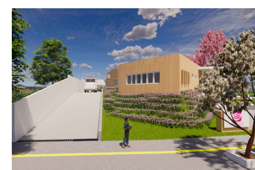
Aproximação da fachada frontal
