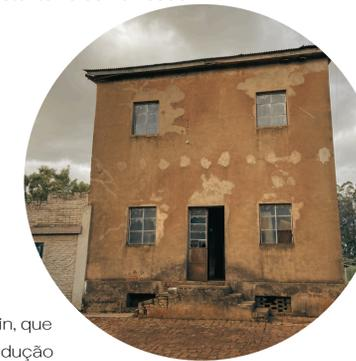
A edificação é composta por estrutura com **dois pavimentos**, um térreo e outro superior, sem divisões no ambiente interno além da própria estrutura utilizada para fabricação da farinha, a estrutura conta ainda com um subsolo,
