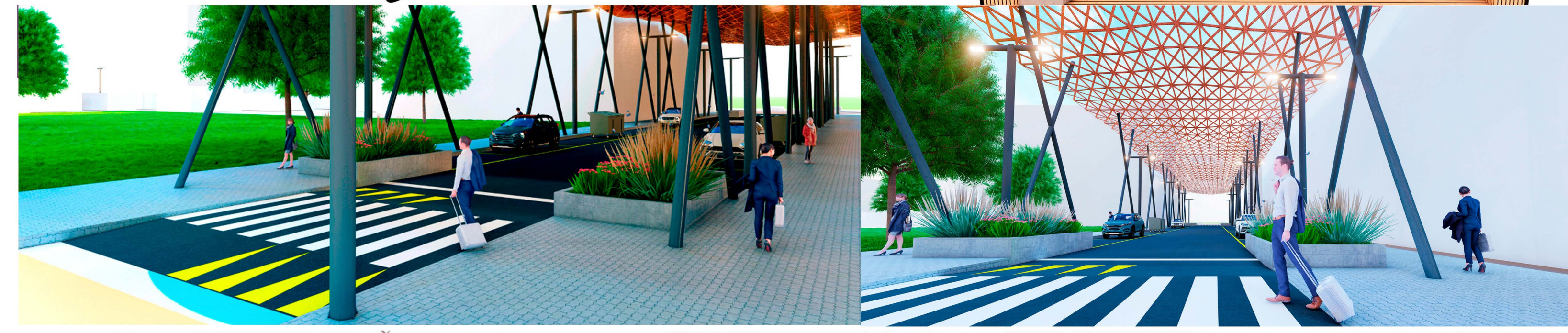
Cobertura em estrutura metálica com policarbonato translúcido
