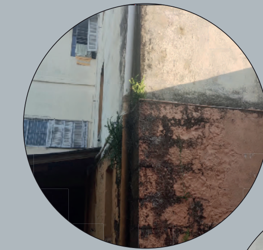
5 - CRESCIMENTO DE VEGETAÇÃO Solução: Remoção da vegetação e posteriormente lavagem com água sanitária.
