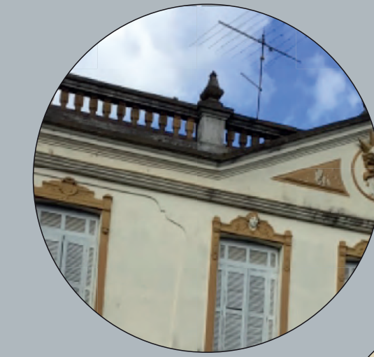
1 - CROSTA NEGRA Solução: Remoção da crosta com lavagem com água sanitária.
