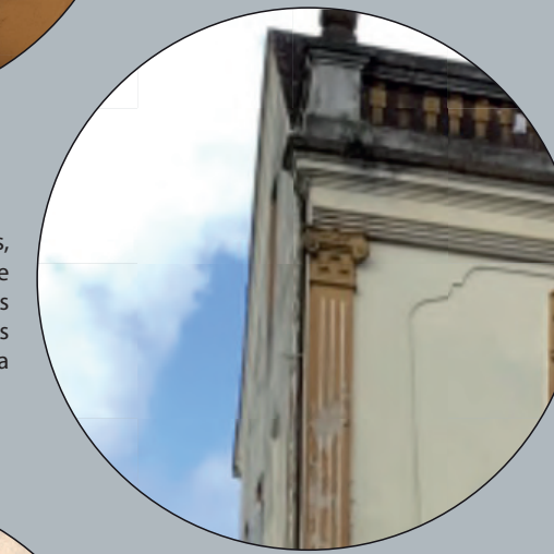
5 - CRESCIMENTO DE VEGETAÇÃO Solução: Remoção da vegetação e posteriormente lavagem com água sanitária.
