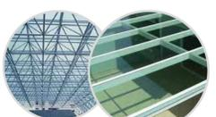
Sistema de treliça espacial metálica ancorada em pilares do tipo árvore com hastes e cobertura de vidro laminado com inclinação;
