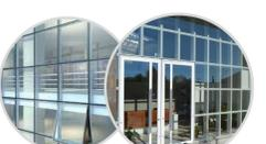
Sistema de fachada estrutural glazing com vidro temperado laminado e perfis metálicos;
