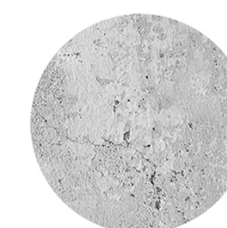
Estrutura em concreto
