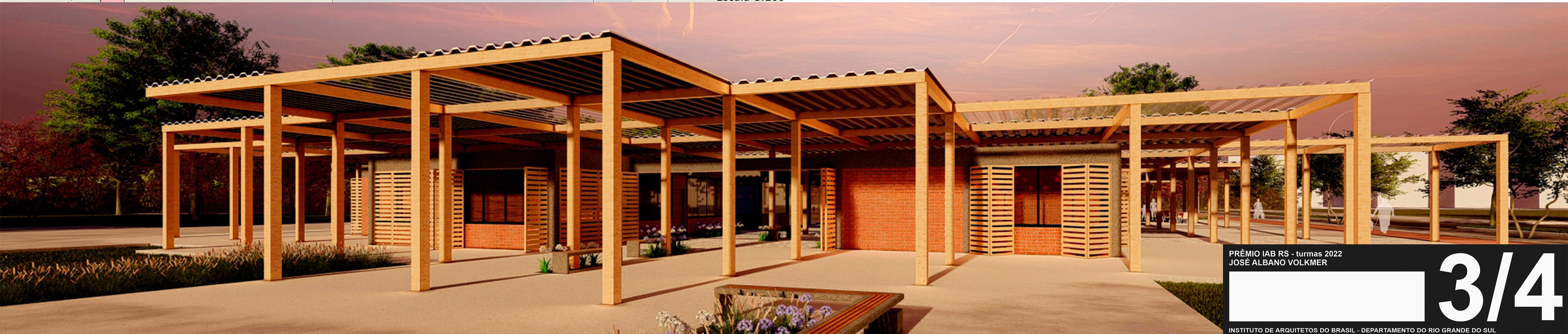
Fechamento em tijolo cerâmico e venezianas articuladas em pinus (paletes reutilizados)
