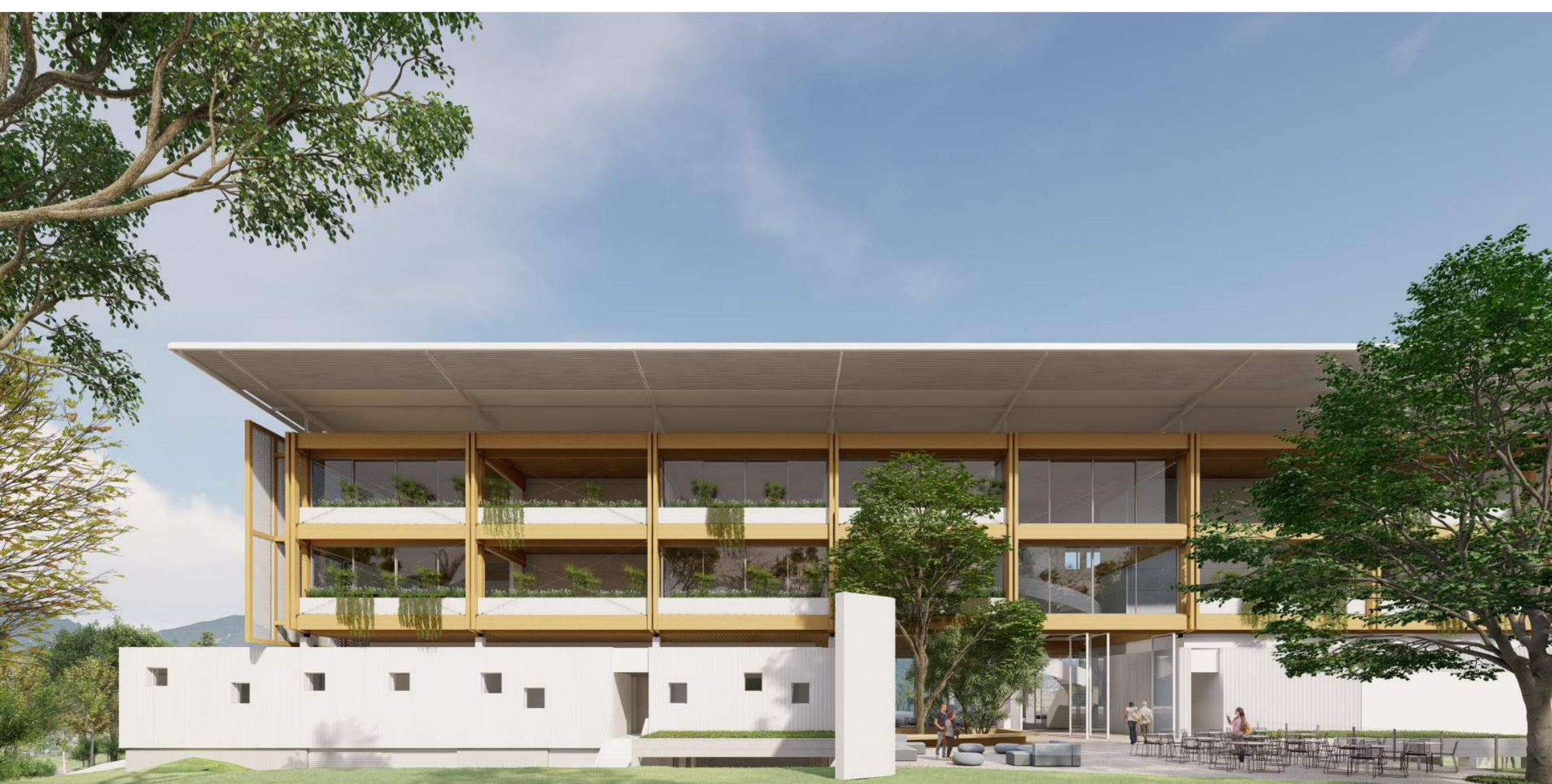
Fachada posterior | salas de aula sob setor de serviço
