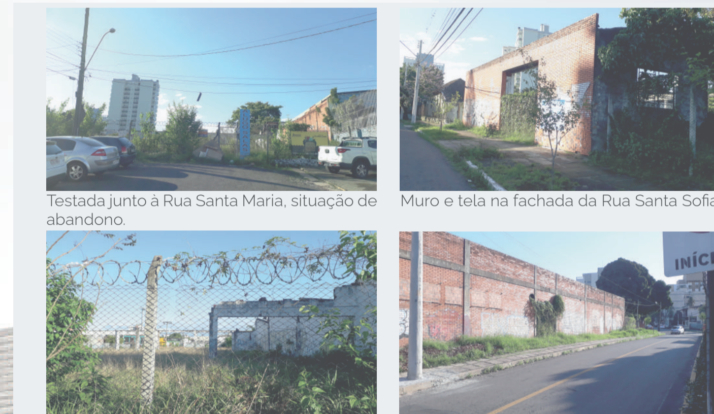
Testada junto à Rua Santa Maria, situação de abandono.
