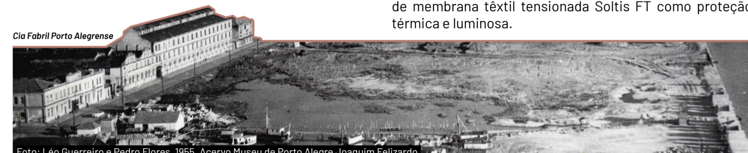
Na foto a cima podemos observar a Cia Fabril Porto Alegrense e identificar algumas transformações ao longo do tempo, como a demolição da cobertura em formato de lanternim e posterior adição da torre lateral (ainda inexistente nessa foto), além disso o processo de aterramento do Cais Navegantes com os trapiches.
