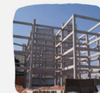
Sistema estrutural independente de concreto armado
